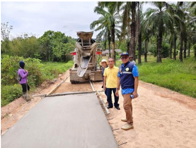
๒๕. โครงการก่อสร้างถนนคอนกรีตเสริมเหล็ก ซอย ๔ หมู่ที่ ๙
