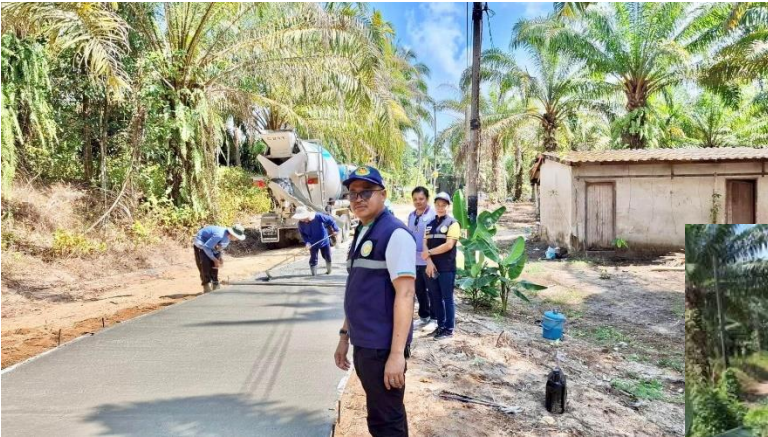
๒๑. โครงการถนนคอนกรีตเสริมเหล็ก ซอยป่าคลอก หมู่ที่ ๖
