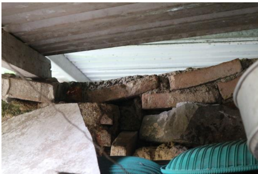
ภาพที่ 160 อิฐบริเวณกำแพงและตัวอย่างอิฐที่หลุดออกมาจากกำแพง
